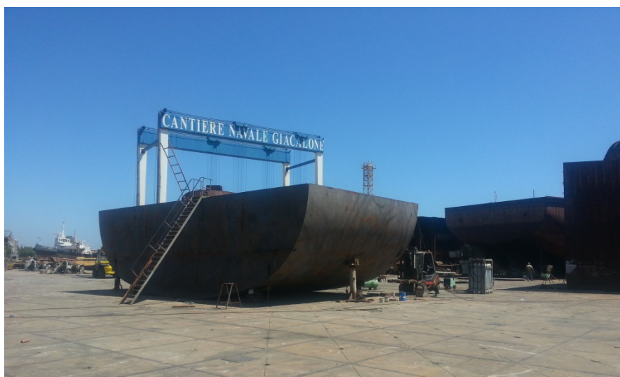
Figura 8. Il sistema ISWEC 100 kW: realizzazione dello scafo
