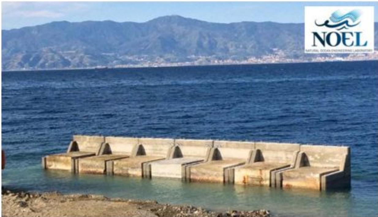
**Figura 4.** Diga in cemento armato, presso il NOEL di Reggio Calabria.
