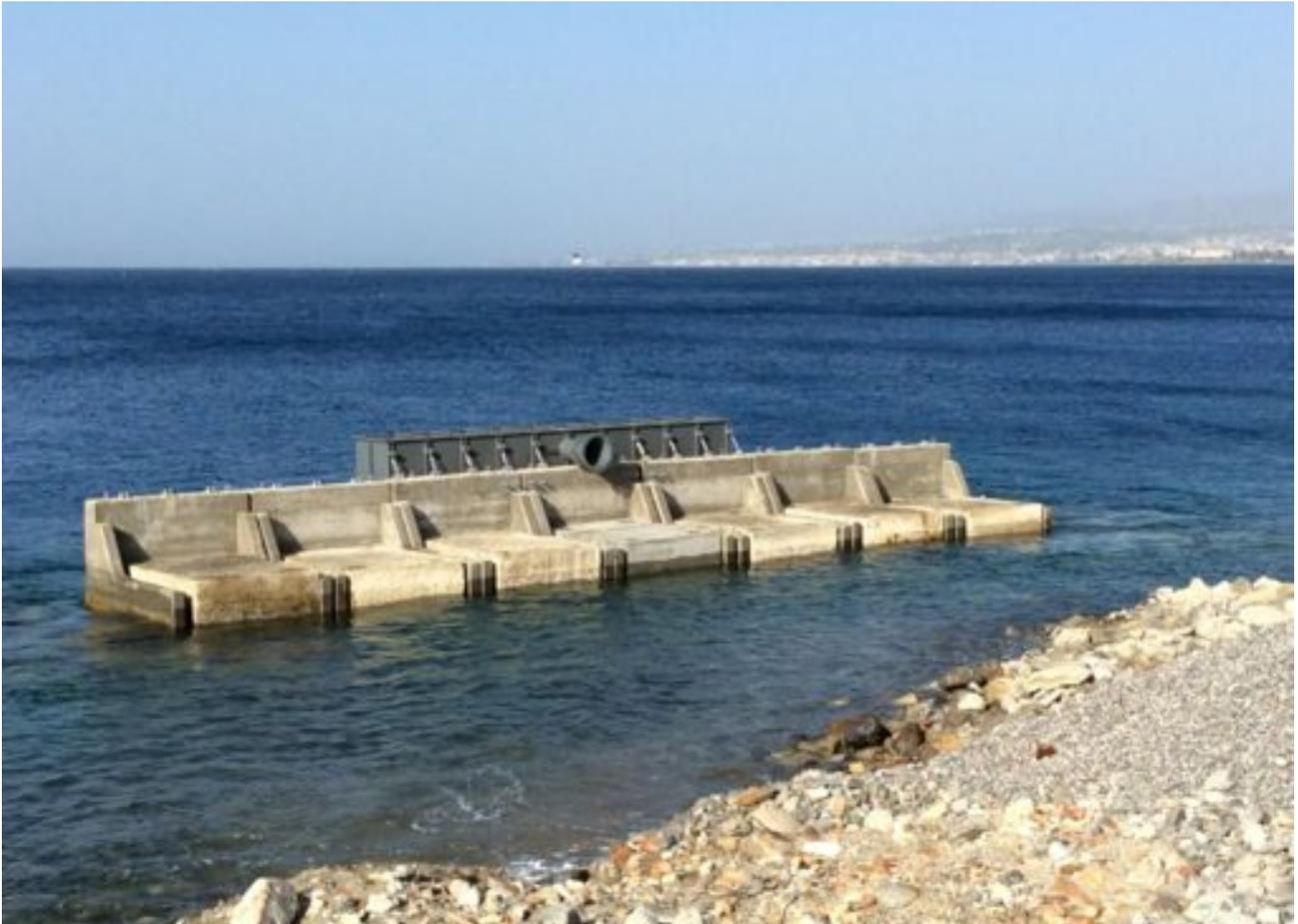
**Figura 6.** Il cassone metallico REWEC3 installato sulla diga in cemento armato presso il NOEL.
