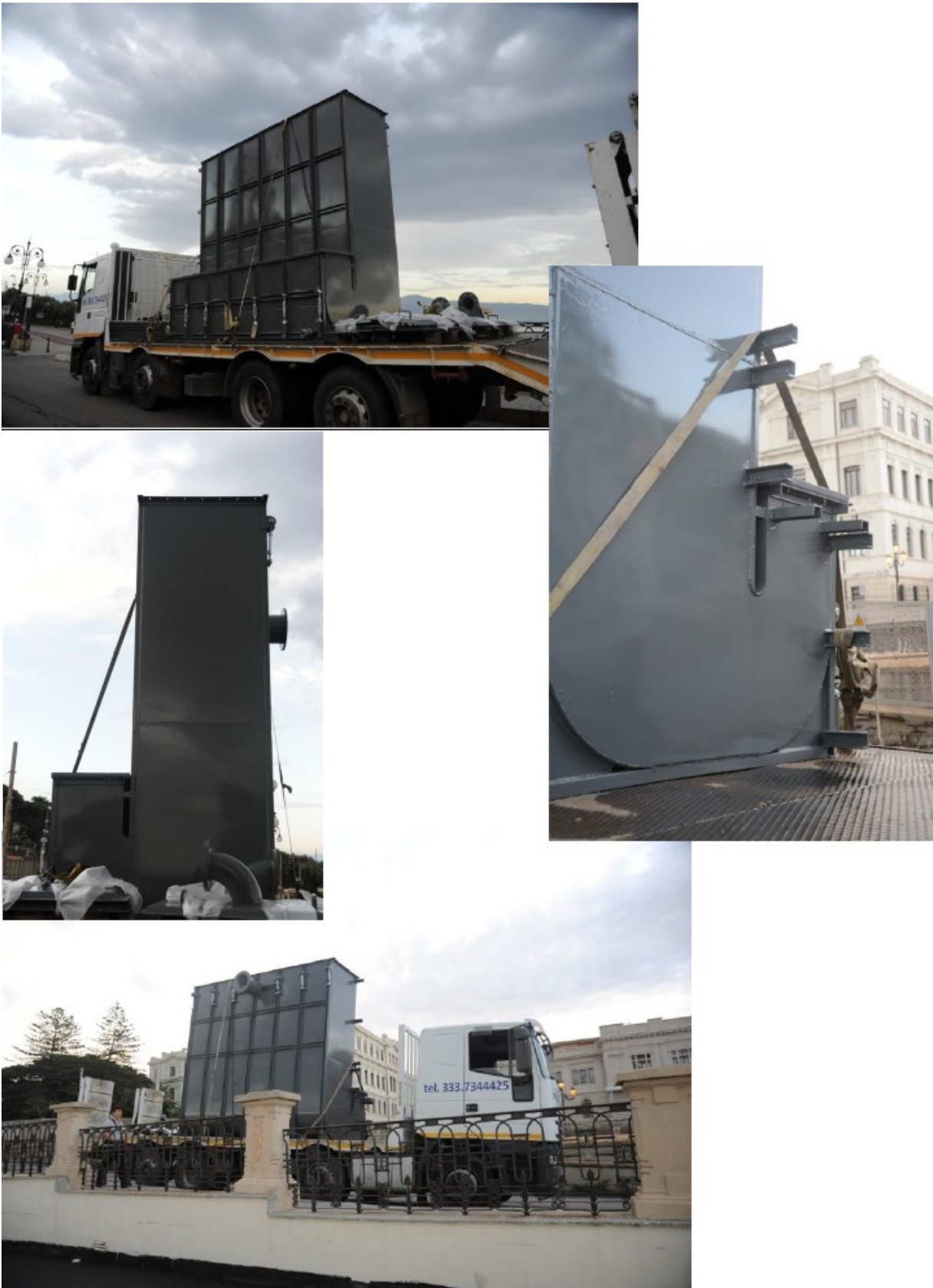
Figura 13. Trasporto del cassone in acciaio dall'officina meccanica al Natural Ocean Engineering Laboratory. Particolare dell'imbocco sommerso del condotto verticale (a destra).
