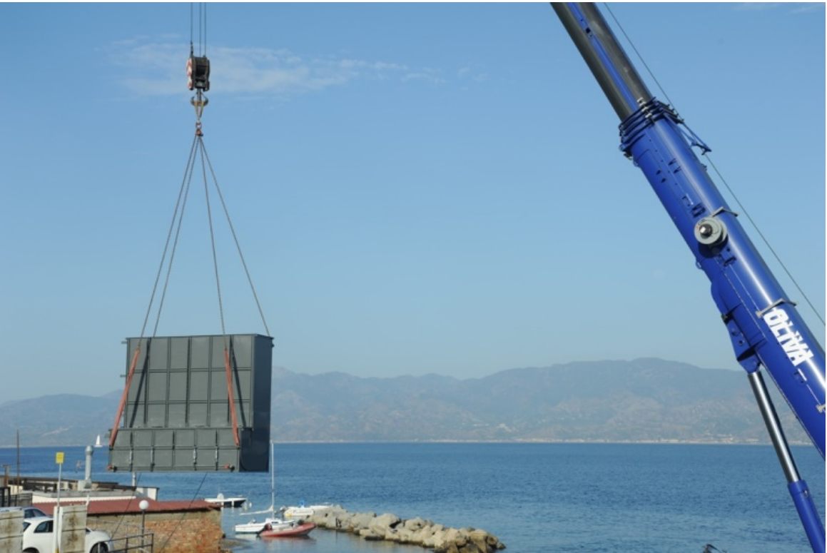
Figura 19. Fasi della posa del cassone in acqua 2/4
