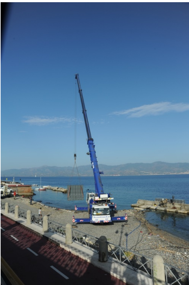
Figura 20. Fasi della posa del cassone in acqua 3/4
