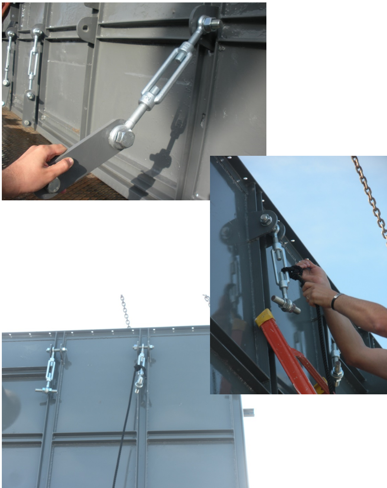
Figura 23. Gruppi tendicavo per il fissaggio della parte superiore (lato terra) ed inferiore (lato mare) del cassone in acciaio alla struttura in cemento armato
