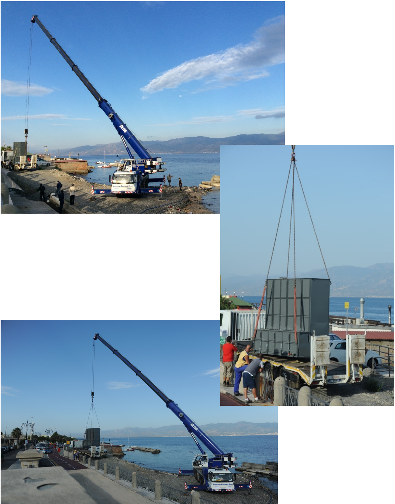
Figura 18. Fasi della posa del cassone in acqua 1/4
