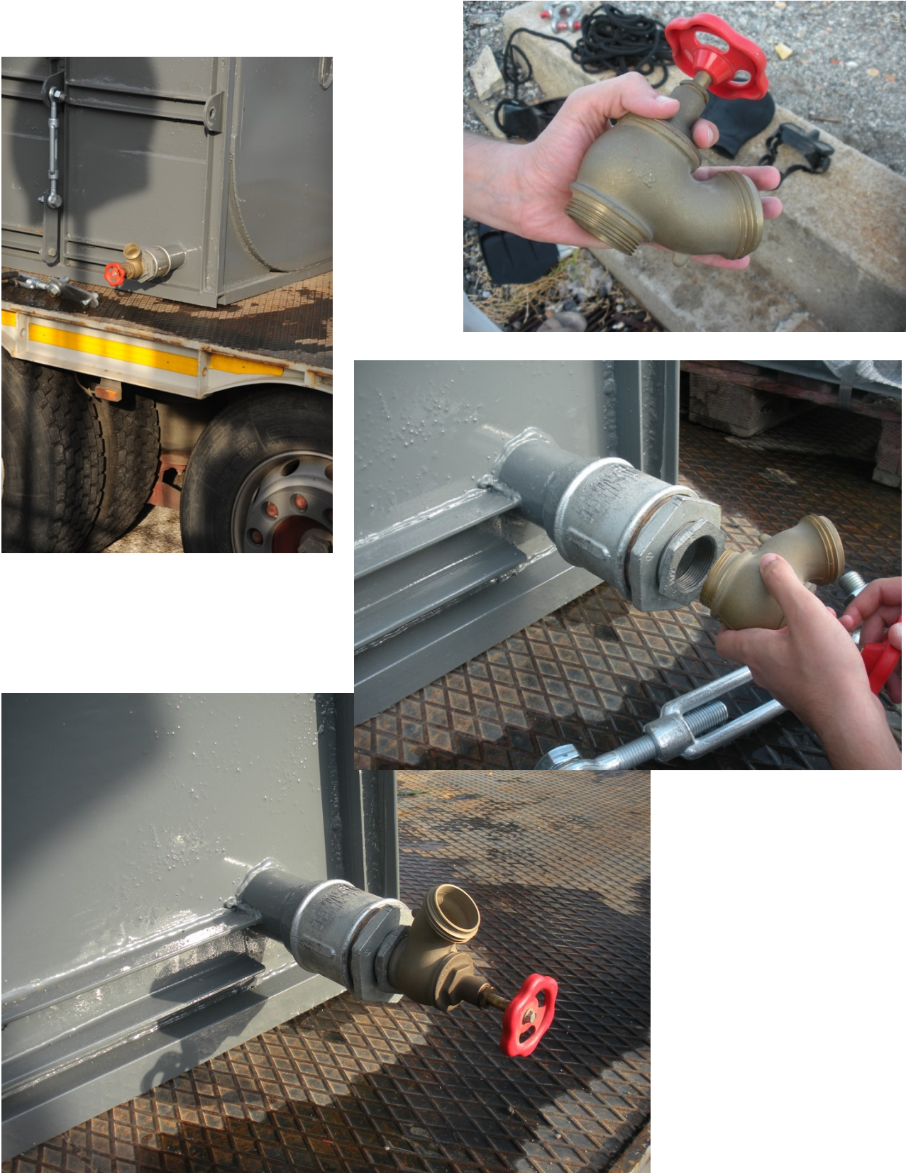
Figura 22. Una delle due valvole fissate sul fondo del cassone per l'allagamento, finalizzato all'affondamento del cassone.
