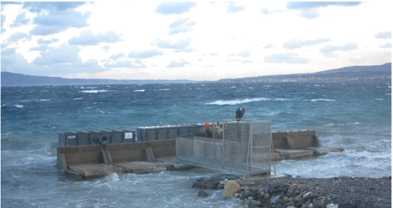
Figura 4. Diga in cemento armato, presso il NOEL di Reggio Calabria, con i due cassoni REWEC3. Sulla sinistra è visibile il REWEC3-GV.
