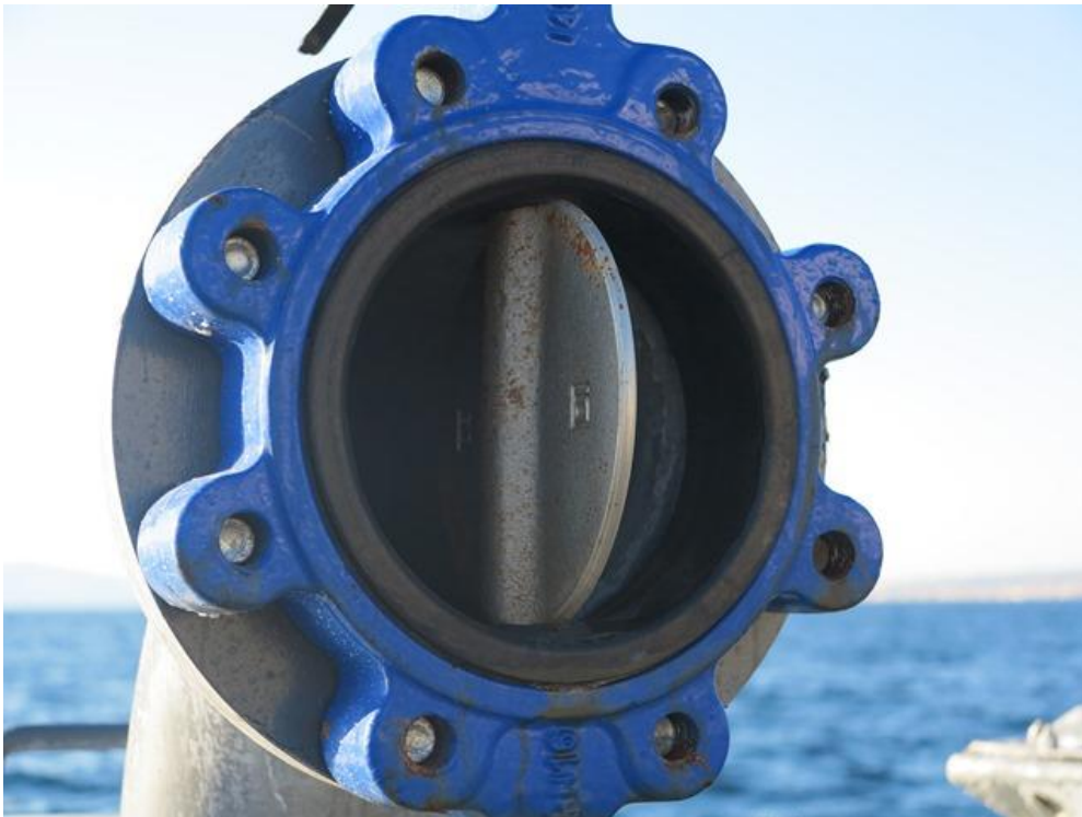
Figura 11d. REWEC3-GV: particolare della valvola a farfalla.
