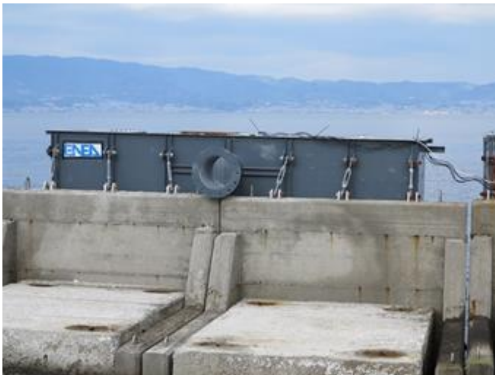
Figura 5. Particolare del cassone REWEC3-GV.
