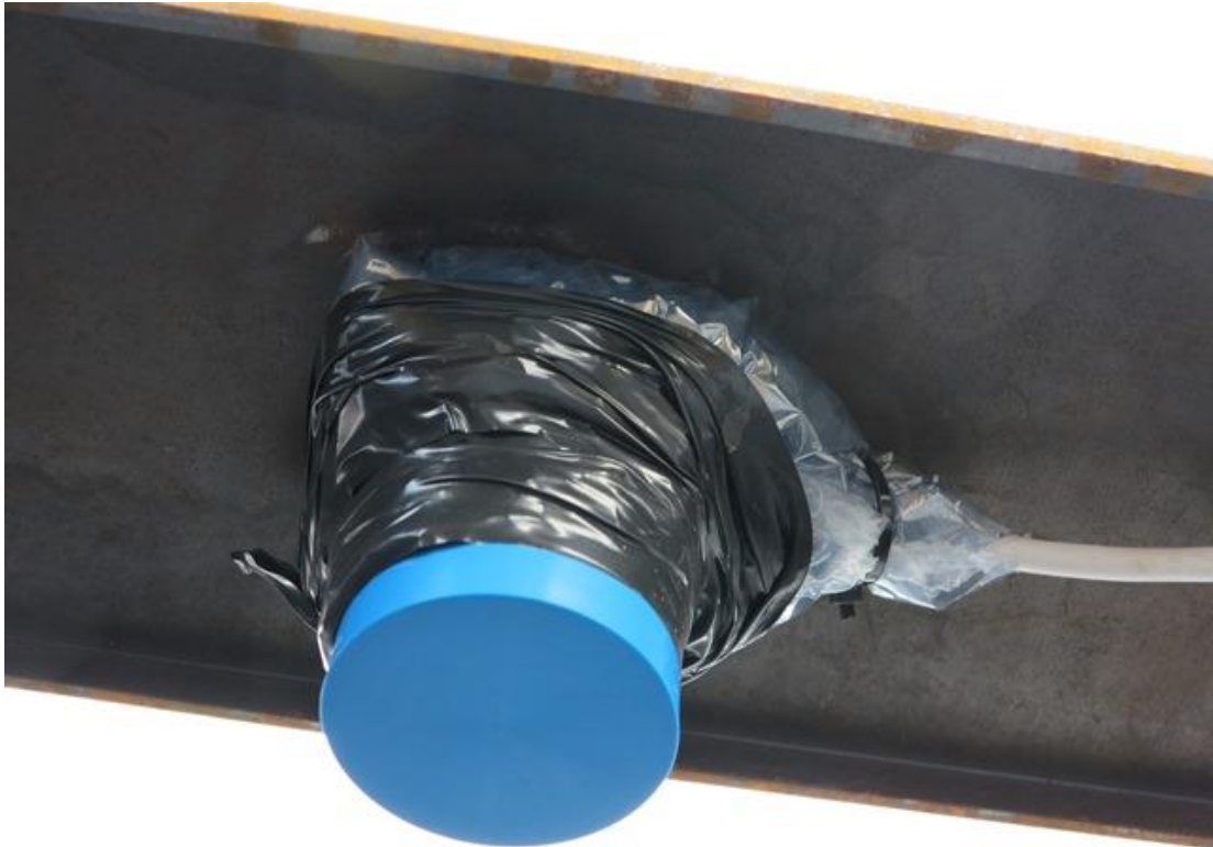
Figura 7. Sonda a ultrasuoni, per le misure di livello, montata sulla camera di assorbimento del assone REWEC3-GV
