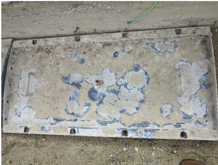
Figura 10. Passerella per l'accesso al cassone e coperchio del condotto verticale impiegato durante il posizionamento del cassone REWEC3-GV.
