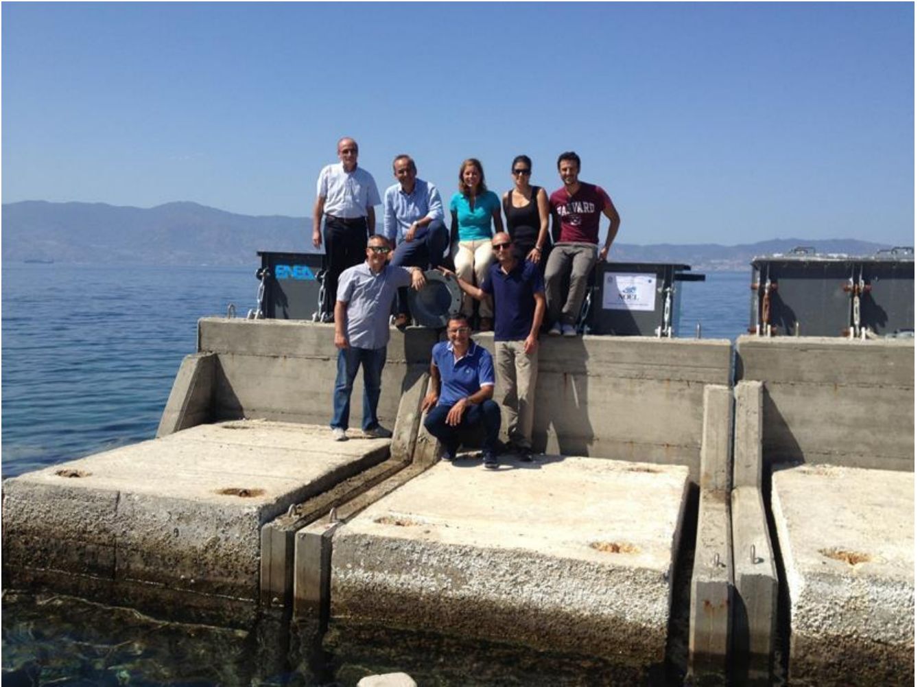
Figura 3. Il cassone REWEC3-GV dopo l'installazione presso il NOEL.
