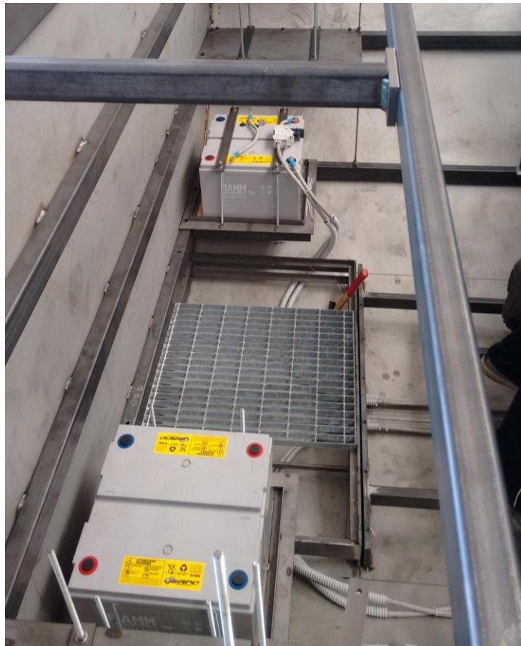
Figura 24 – Le batterie di bordo
