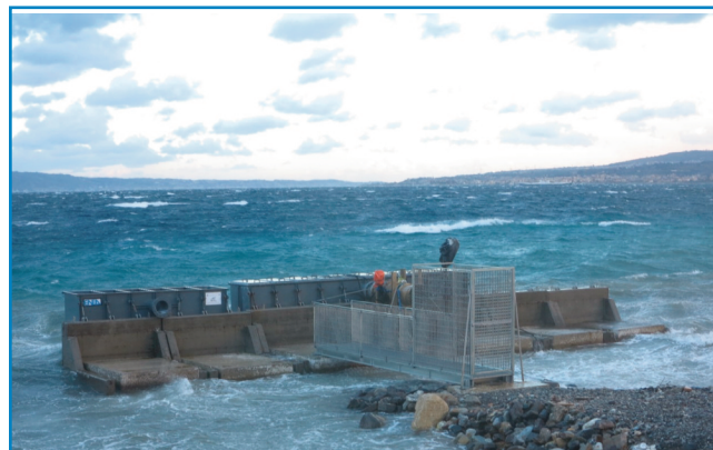
Diga in cemento armato, presso il NOEL di Reggio Calabria, con i due cassoni REWEC3
