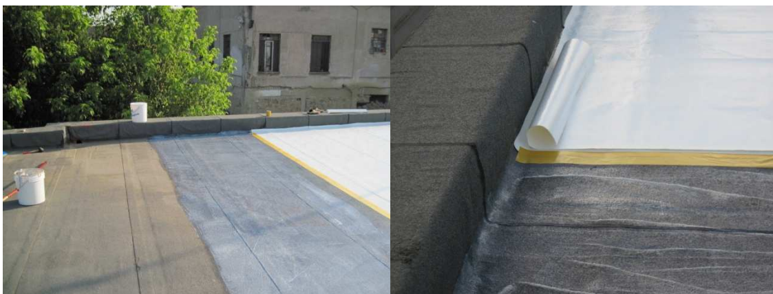
Figura 4: Stesura del biadesivo sulla membrana
