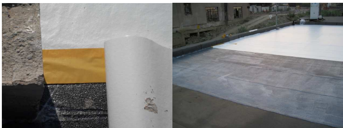
Figura 5: Sovrapposizione della membrana alla striscia di biadesivo
