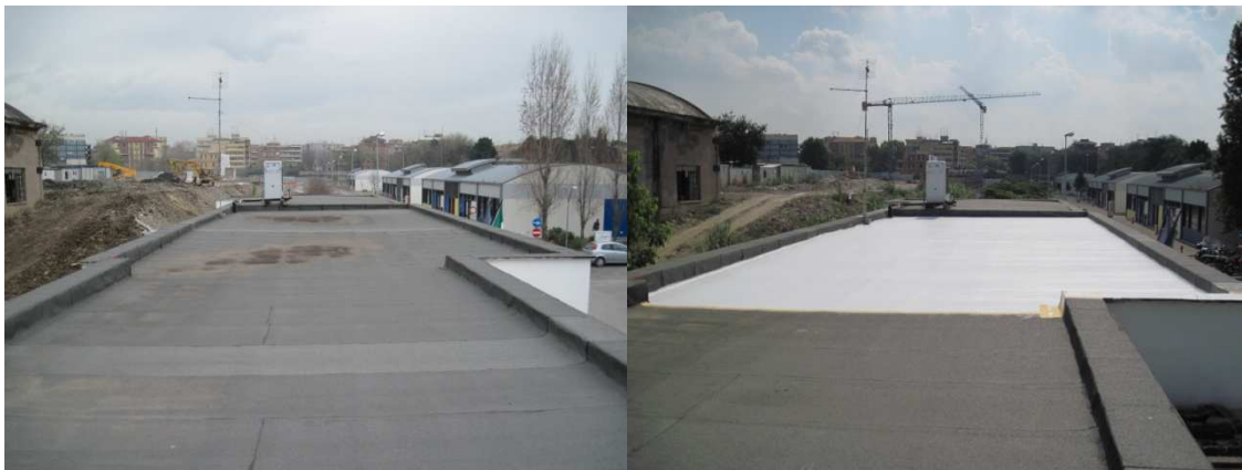
Figura 6: Porzione di tetto prima e dopo l'applicazione della membrana termo - riflettente
