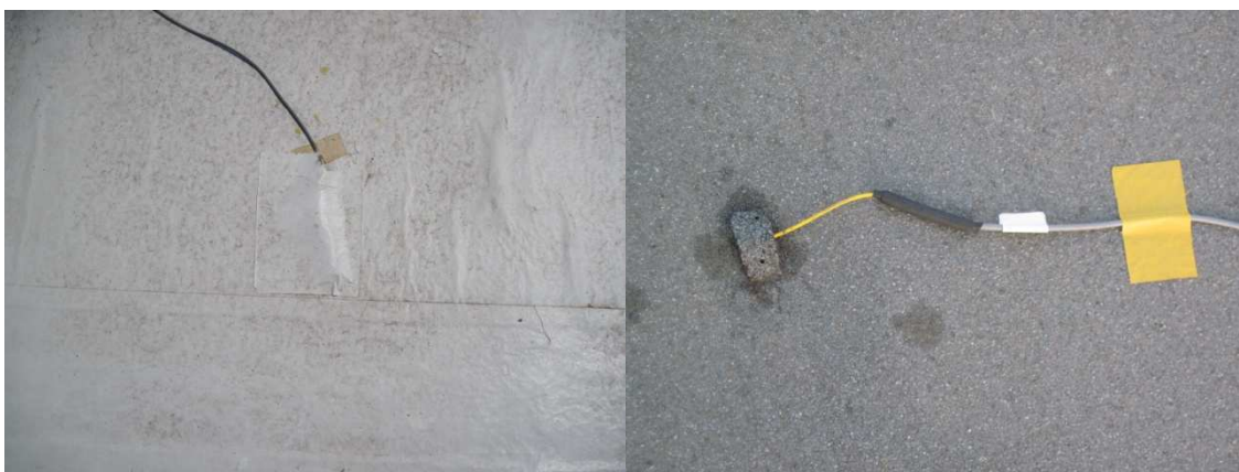
Figura 9: Termo - Resistenze montate sulla copertura
