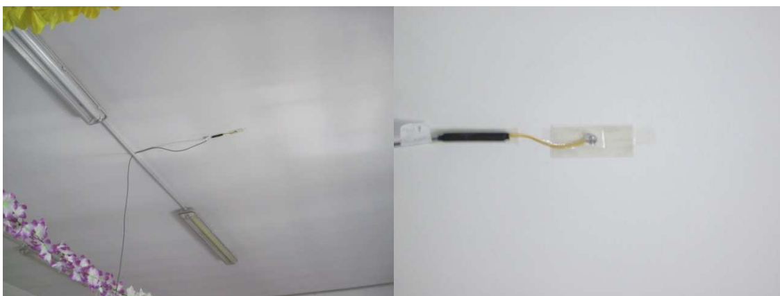
Figura 10: Termo – Resistenze montate sulla superficie interna del solaio di copertura
