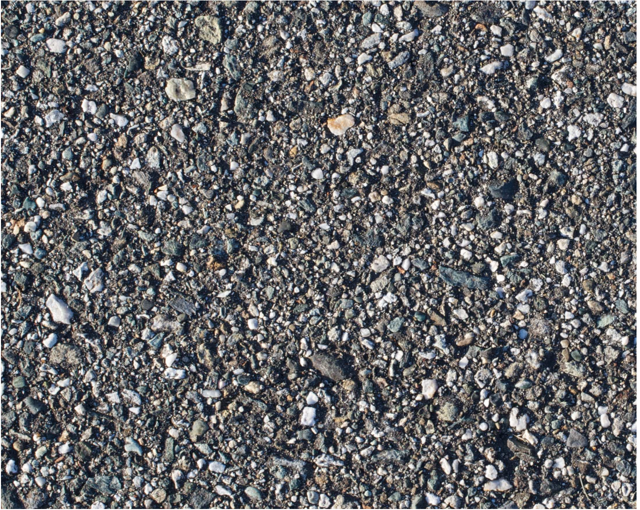
Figura 9 Sito sperimentale: particolare dell'asfalto non trattato.
