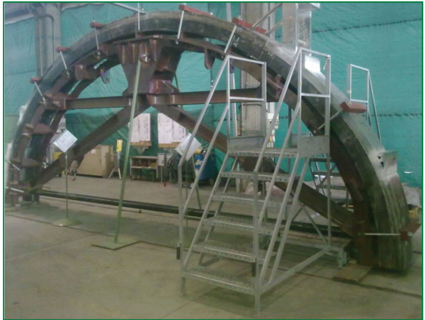
Gamba curva in fase di saldatura degli accessori esterni
