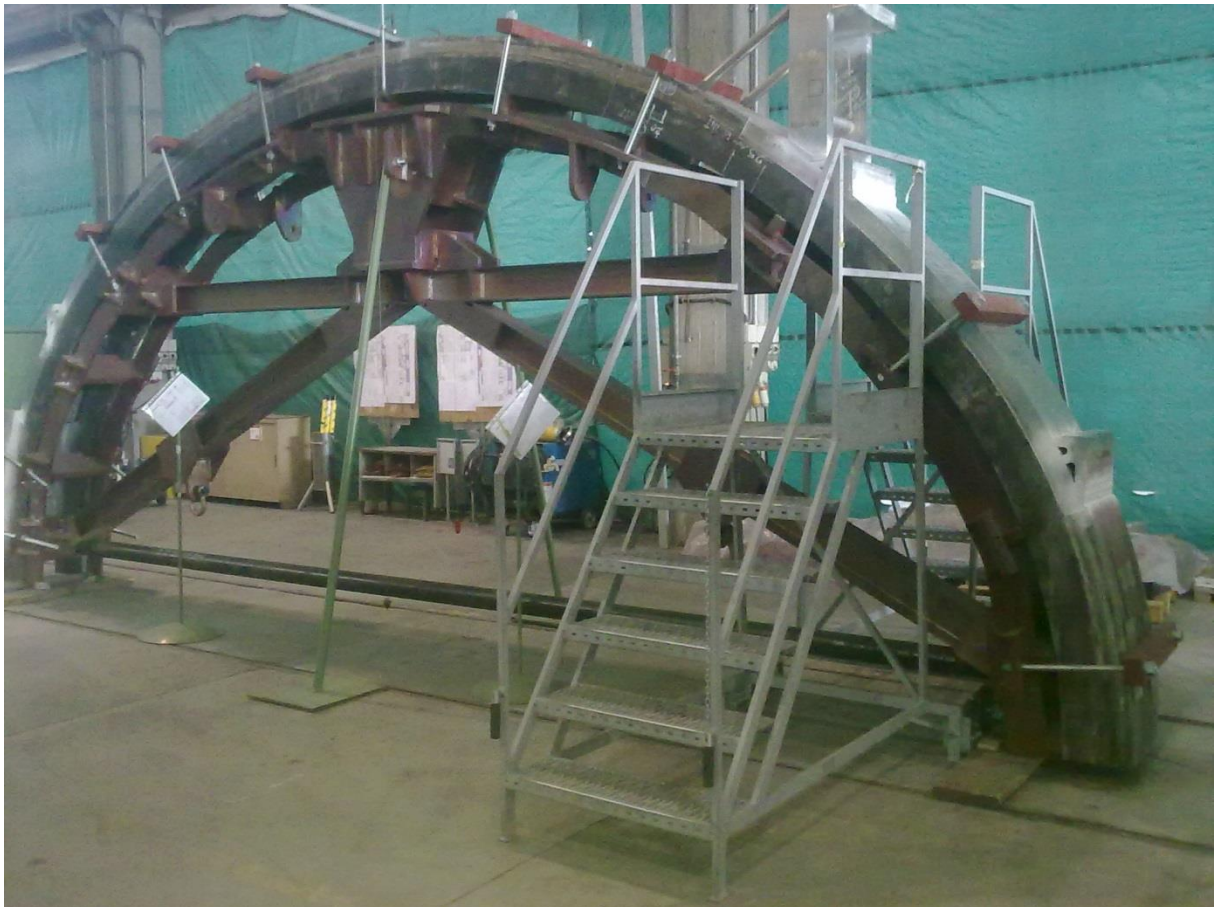
Figura 6: Gamba curva in fase di saldatura degli accessori esterni
