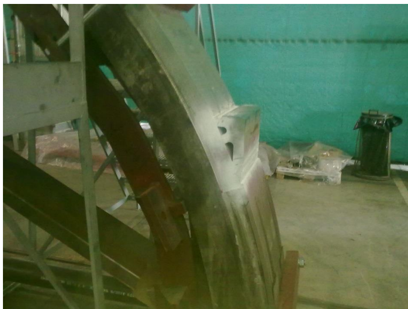
Figura 8: Supporto saldato sulla gamba curva
