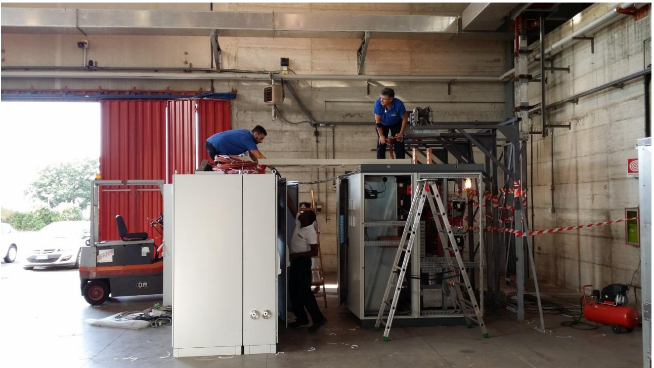
Figura 33. Preparazione delle prove nella Sala Convertitori del Centro Ricerche ENEA di Frascati. Le barre sulla destra, costruite appositamente per le prove sul prototipo riproducendo le barre di JT-60SA, provengono dal circuito di alimentazione di FTU.
