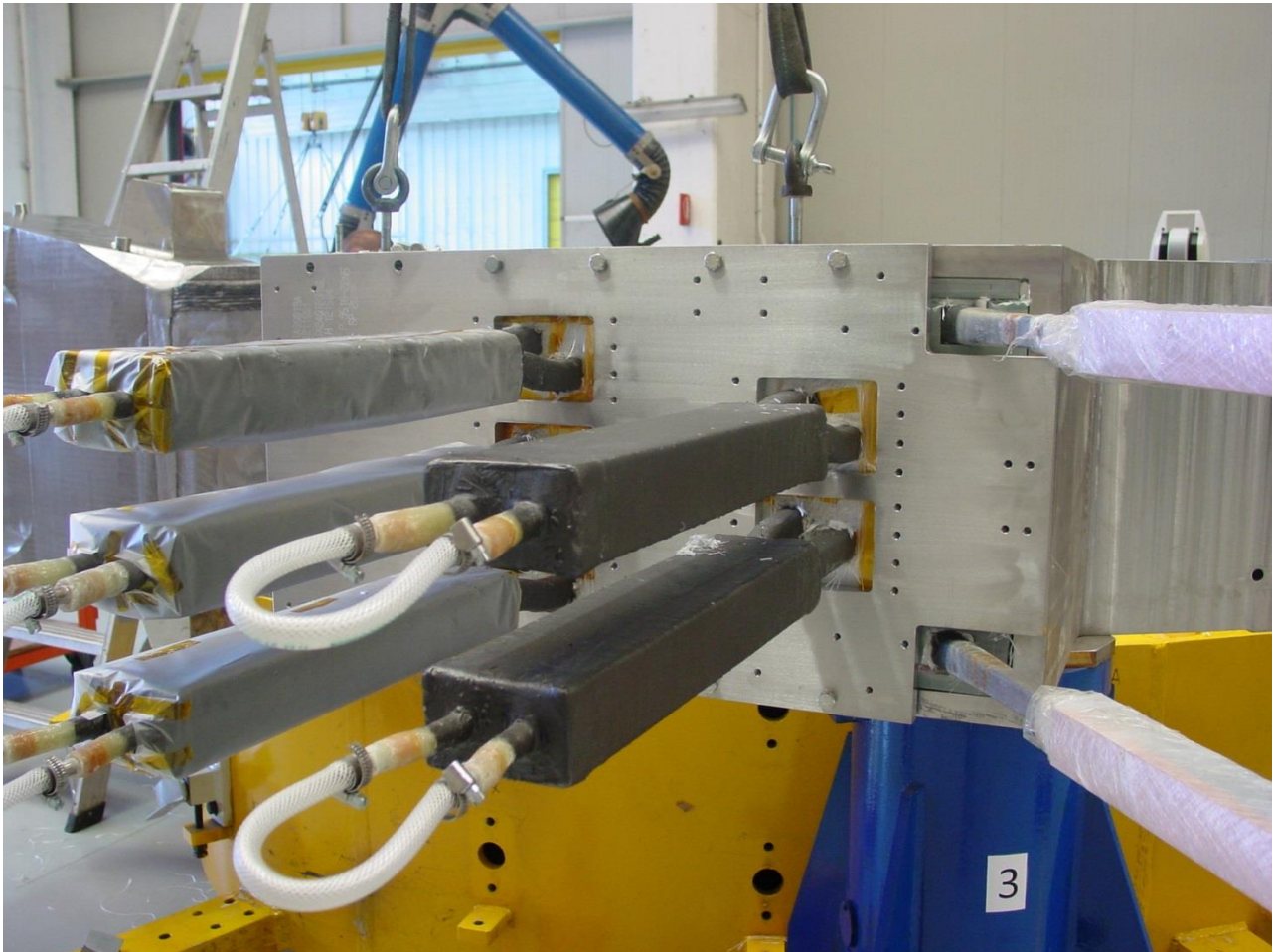
Figura 28 Chiusura port verticale giunti elettrici
