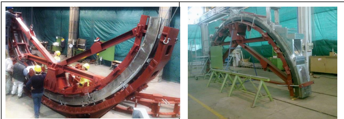
Figura 4: Attrezzature per la composizione della gamba curva e saldatura dei supporti.
