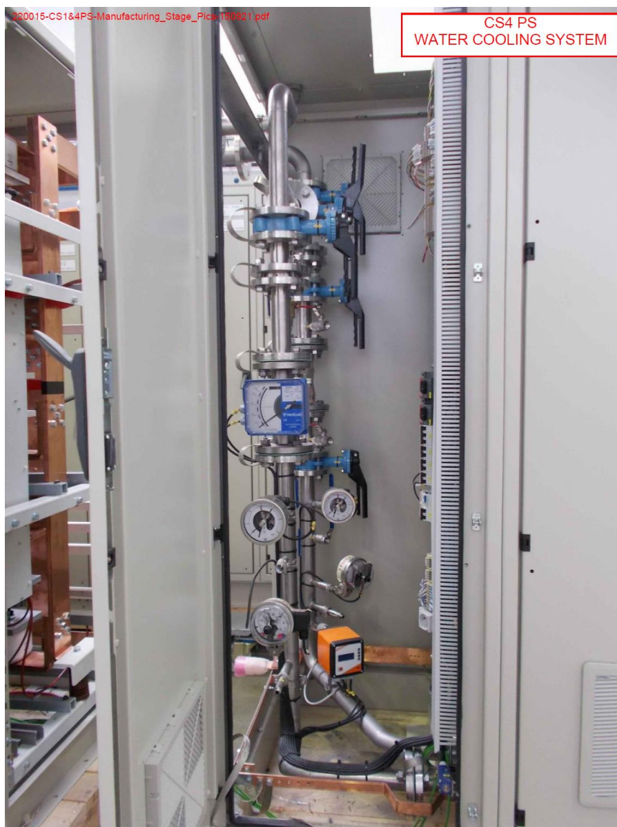
Figura 13 - Sistema di raffreddamento del CS4
