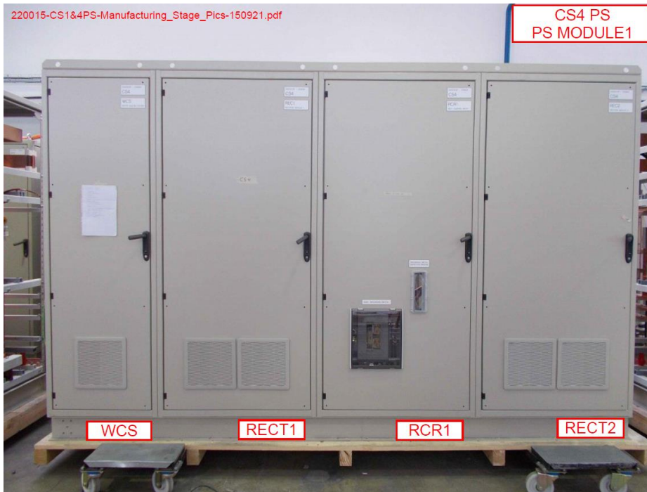
Figura 11 - Realizzazione del modulo 1 del CS4.
