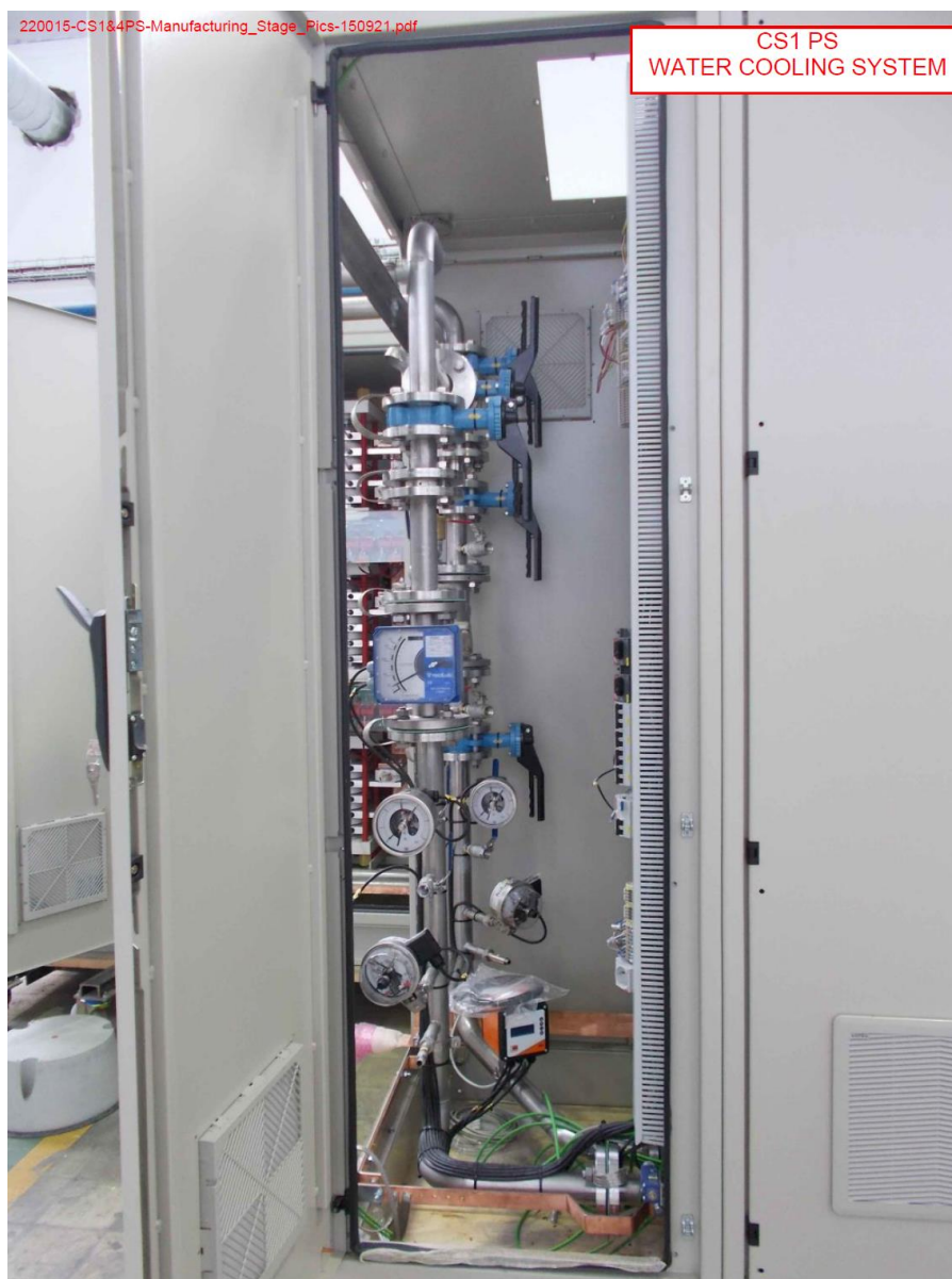
Figura 10 - Sistema di raffreddamento del CS1.
