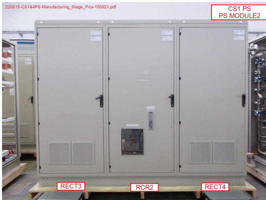
Figura 9 - Realizzazione del modulo 2 del CS1
