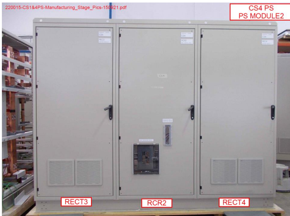
Figura 12 - Realizzazione del modulo 2 del CS4
