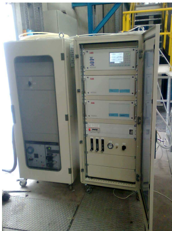
Fig. 6: Analitica modulare e sinottico di interfaccia con l'operatore
