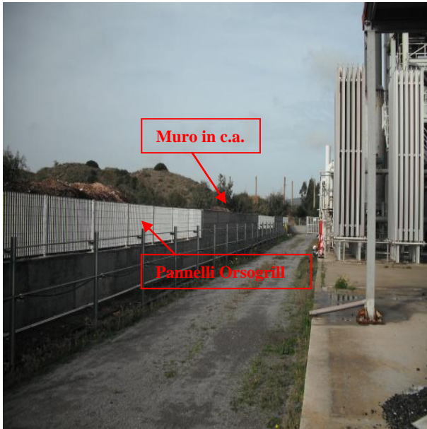
Figura 10 . Recinzione perimetrale impianti
