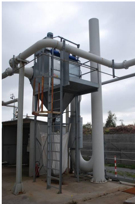
Figura 2.4. Sistema di aspirazione delle polveri.
