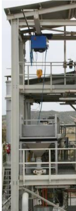
Figura 2.3. Sistema di caricamento del carbone con paranco e tramoggia di carico.
