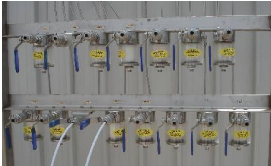
Figura 2.12. Pannello collettore delle prese di campionamento.
