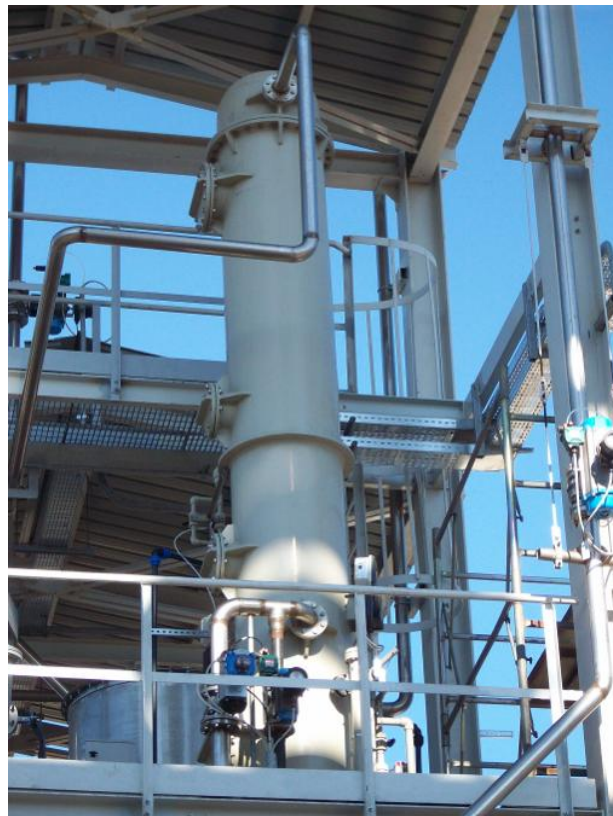
Figura 2.3. Colonna di desolforazione a freddo del syngas.
