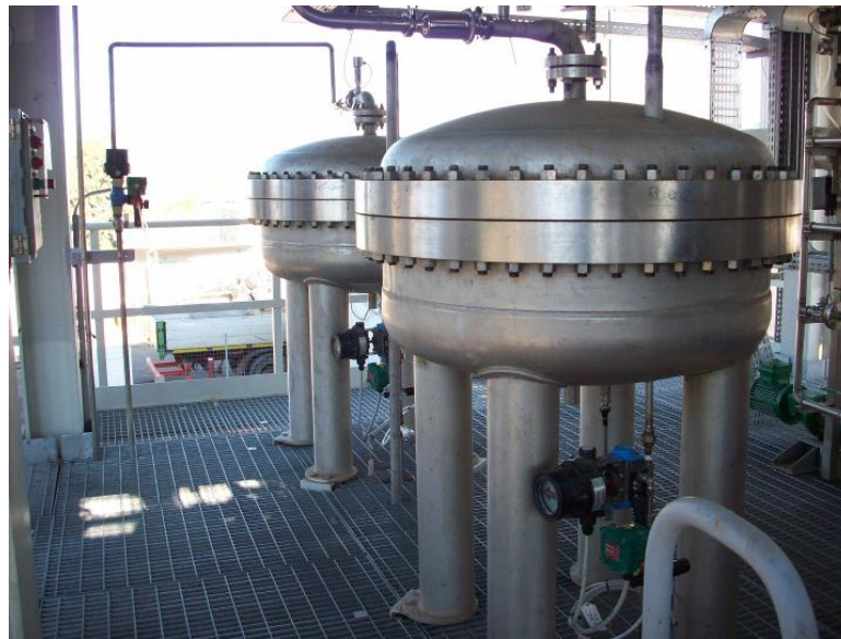
Figura 2.8. Reattori di assorbimento dell'anidride carbonica.
