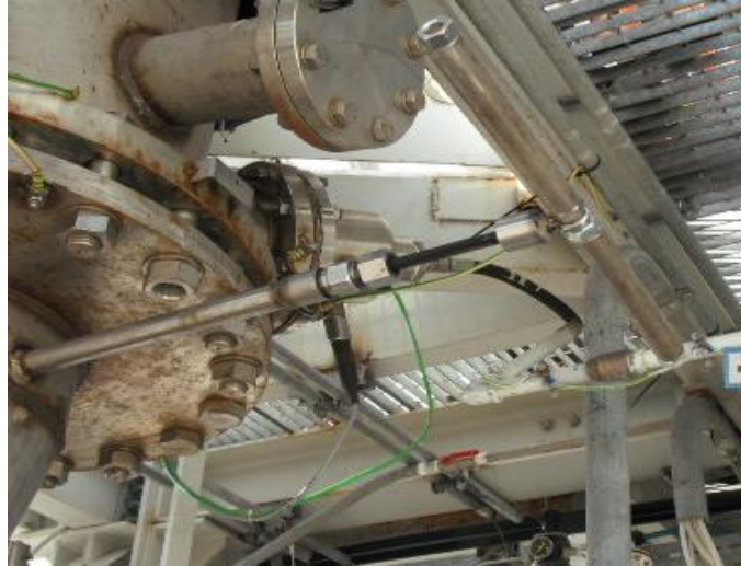
Figura 3.10 Manubrio per la movimentazione manuale della griglia
