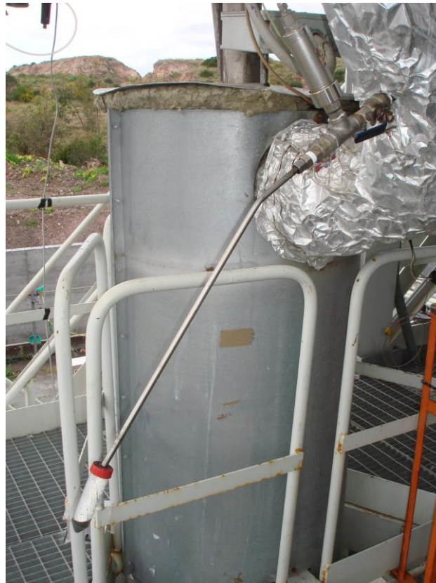
Fig. 8 – Punto di campionamento di TAR e polveri realizzato a valle del gassificatore
