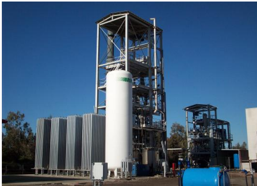
Figura 1 . La piattaforma pilota Sotacarbo.
