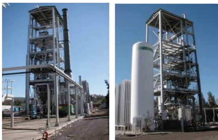
ENEA/SOTACARBO Piattaforma pilota per la produzione di energia elettrica e idrogeno da carbone
