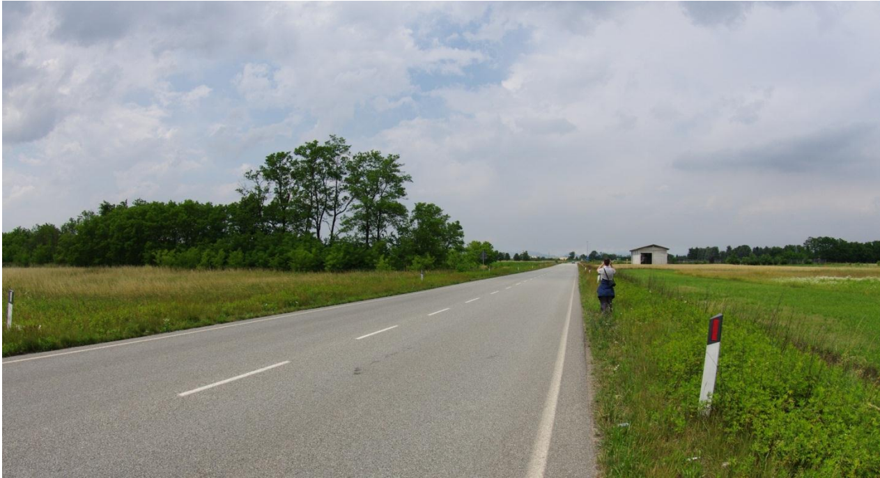
Figura 2 Sito oggetto delle prove di impianti di tipo extraurbano. Gli impianti di illuminazione sono stati installati, sul lato destro della carreggiata, nel tratto compreso tra gli alberi a sinistra e la bassa costruzione a destra.
