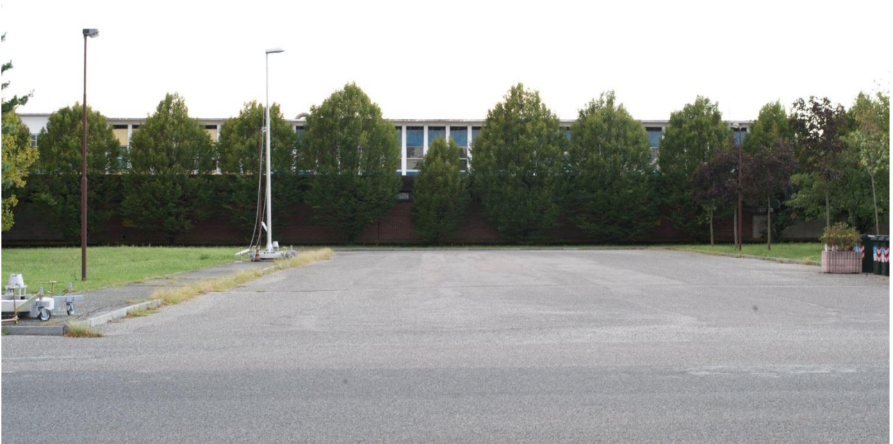
Figura 6 Strada e impianto di illuminazione presente nel sito scelto presso la sede INRIM (Il primo palo a sinistra appartiene all'impianto fisso INRIM, spento durante le prove, il secondo è quello sperimentale).
