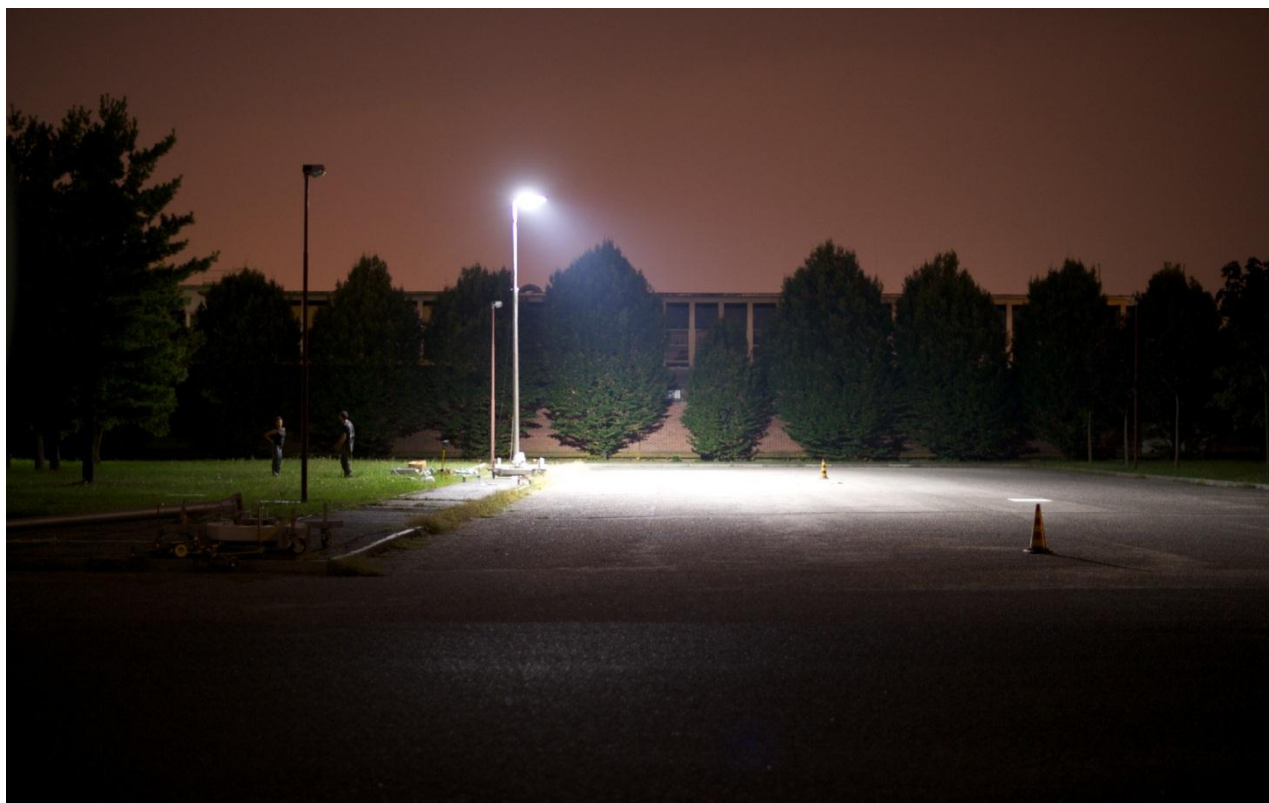
Figura 57 Impianto con apparecchio con vetro piano e con sorgenti LED.
