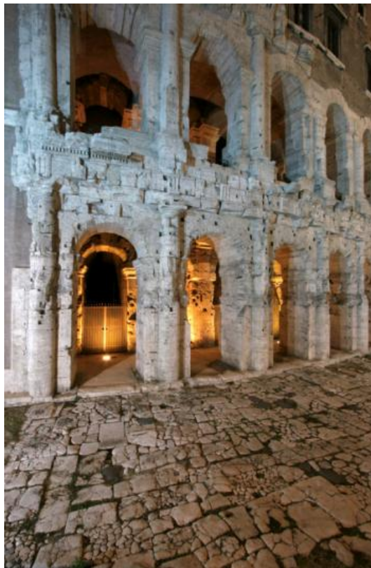
Fig. IV.4. Esempi di eccessiva quantità di luce
