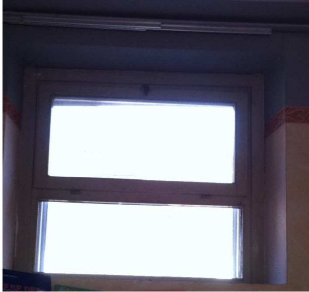
Figura 33 Finestre del lato sinistro rispetto alla porta di ingresso
