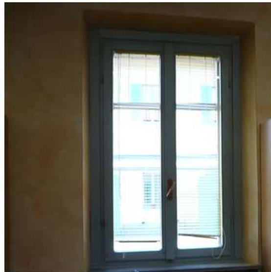
Figura 34 Sistemi di ombreggiatura della porta finestra e della finestra del lato destro rispetto alla porta di ingresso
