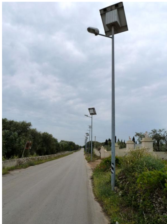
Figura 5.6 – Lampioni fotovoltaici presso Torchiarolo (Brindisi)
