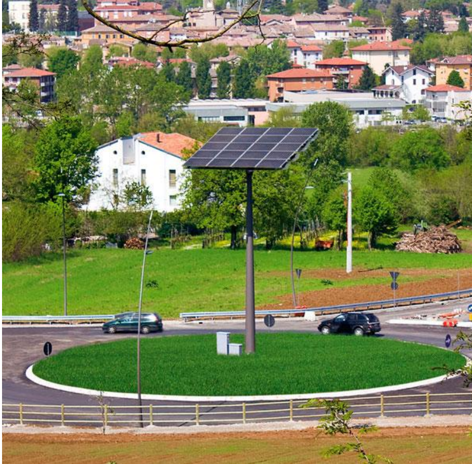
Figura 5.2 – Rotonda a Vignale di Traversetolo (PR) di giorno (l'impianto fotovoltaico produce mediamente 6300 kWh anno con una mancata emissione di CO 2 nell'atmosfera di 3900 kg/anno, inoltre grazie alla tecnologia LED installata il risparmio energetico immediato è superiore al 50%)
