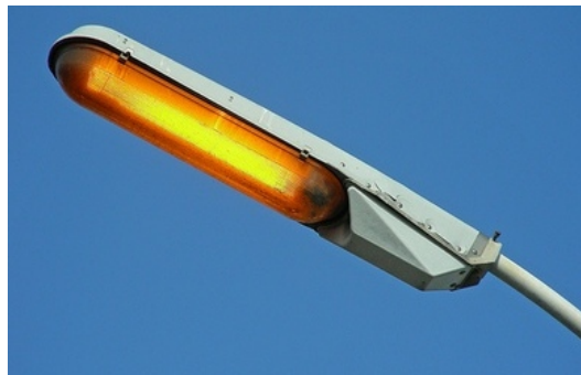
Figura 3.3 - Esempio di apparecchio stradale con sorgente al sodio a bassa pressione – E' evidente come il colore della luce sia molto caldo e di conseguenza come la resa cromatica sia molto scarsa
