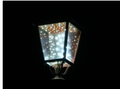
Figure 5.7 e 5.8 - Installazione dei LED nei lampioni esistenti
