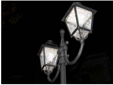
Figure 5.7 e 5.8 - Installazione dei LED nei lampioni esistenti
