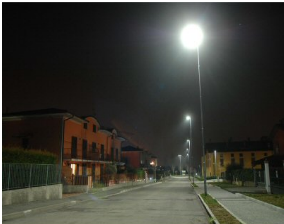
Figura - 5.9 Comune di Solza – illuminazione di via Foglieni
