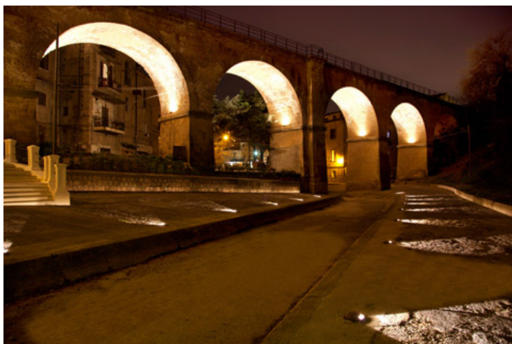
Figura 5.16 - L’illuminazione dell’Ara dei F.lli Bandiera a Cosenza (Simes illuminazione)
