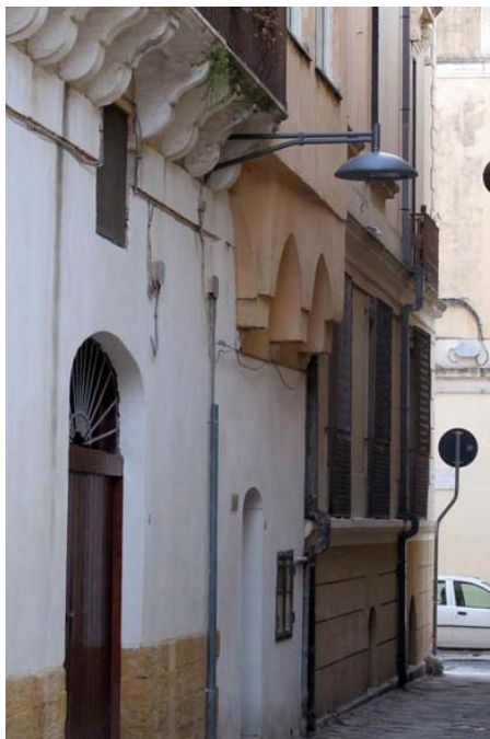
Figura 5.12 Esempio di apparecchio installato al centro di Brindisi
