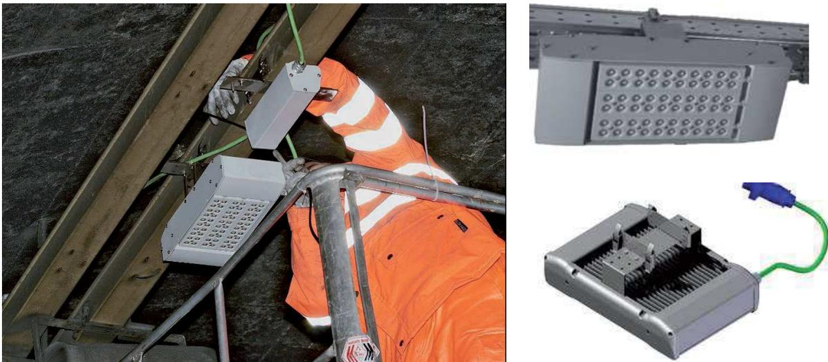
Figura A1.12. L'apparecchio LED Ledway Tunnel, impiegato nella galleria Crocina e nella galleria Vado.
