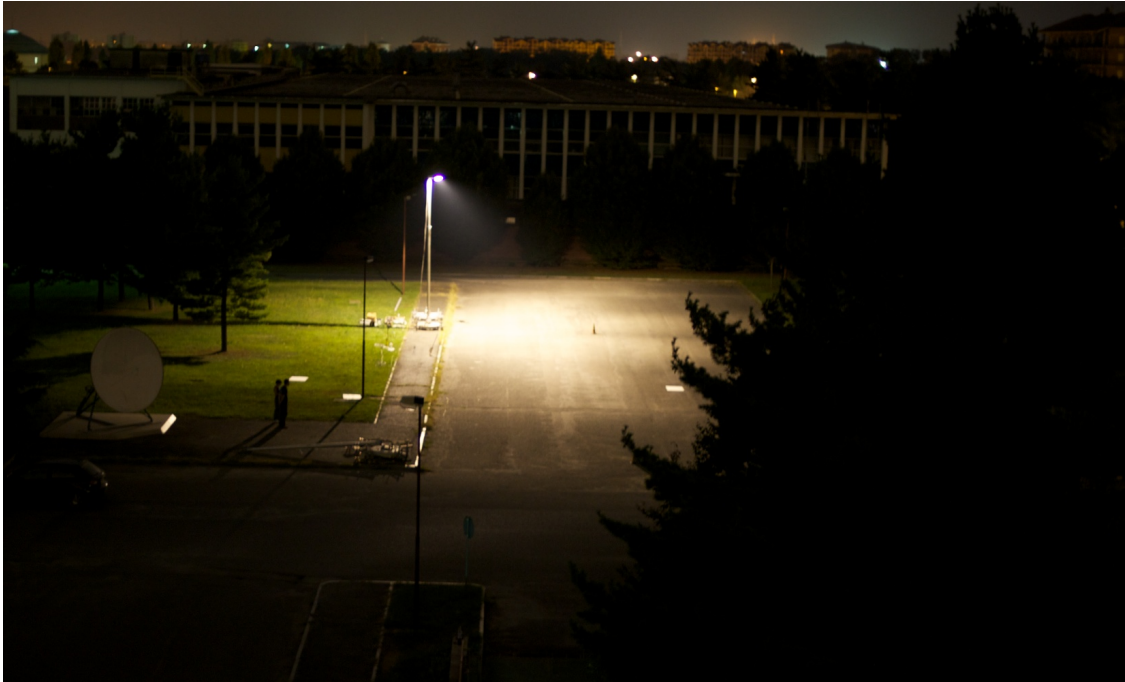
Figura 62 Impianto con apparecchio con vetro curvo e con lampada a ioduri metallici – primo esempio di acquisizione dall'alto – immagine fotografica.
