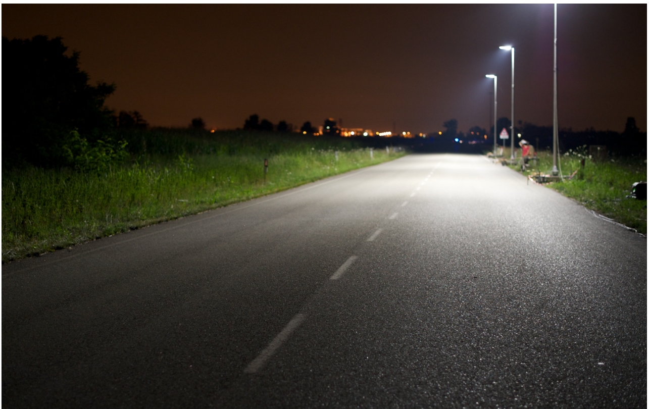
Figura 50 Impianto con apparecchio con vetro piano e con sorgenti LED.
