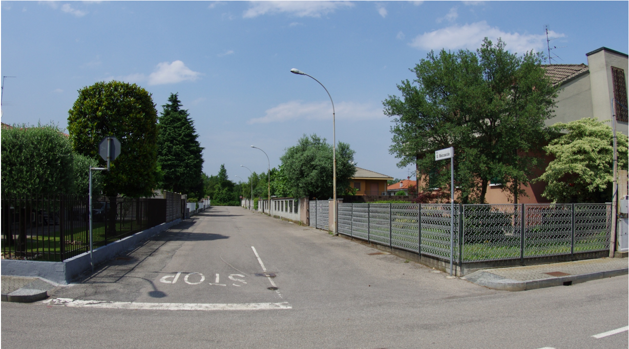
Figura 4 Strada e impianto di illuminazione presente nel sito originariamente previsto per le prove di impianti di tipo urbano.
