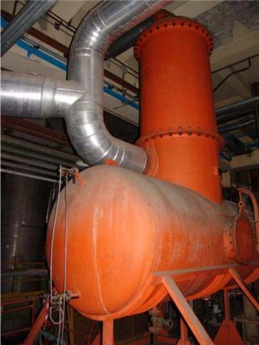
Fig.19 - Separatore per la raccolta del vapore scaricato
