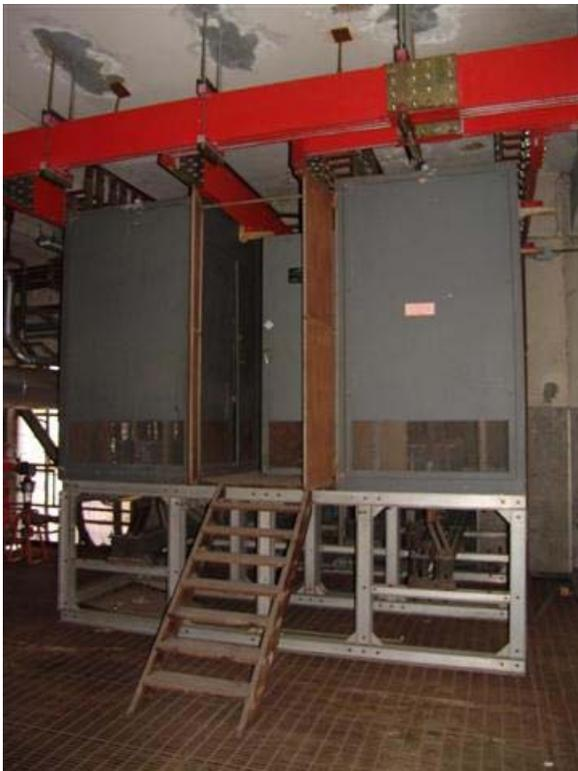
Fig.23 - Gruppo convertitore AC/DC (8MW)
