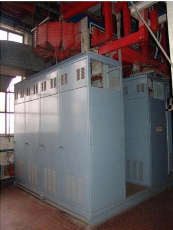
Fig.20 - Gruppo convertitore AC/DC (4MW)
