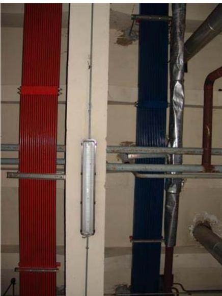
Fig. 26 Sistema di sbarre per alimentazione elettrica barre scaldanti
