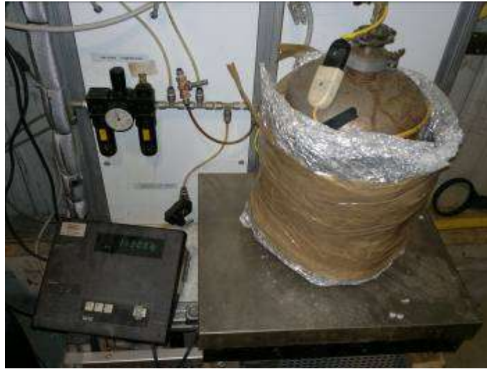
Figura 4 – Particolare impianto CVI – contenitore MTS
