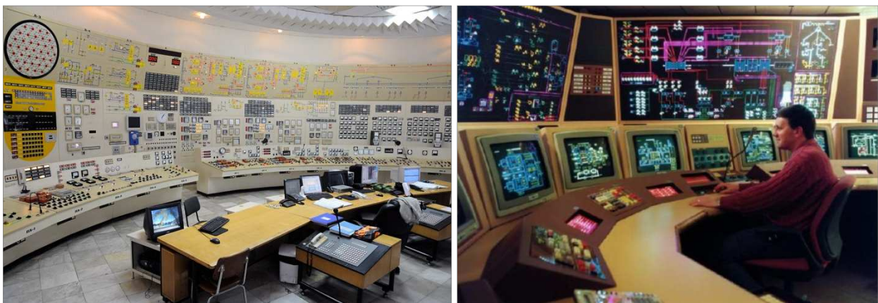
Figura 9 - A sinistra, una comune sala controllo di centrale nucleare; a destra, una moderna sala controllo prettamente digitale.
