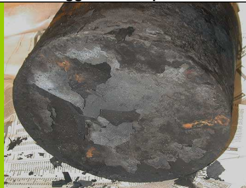
Dettaglio della corrosione esterna
