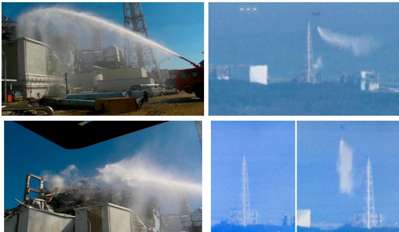
Figura 59. Immagini delle operazioni di spray di acqua sull'edificio dell'unità 3 per riversare acqua sugli elementi di combustibile esauriti.
