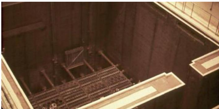
Figura 23. Immagine della piscina di stoccaggio della centrale di Grand Gulf, nel Mississippi, prima dell'avvio dell'impianto (in assenza di combustibile e di acqua). A sinistra è ben visibile il portello per la movimentazione degli elementi di combustibile.
