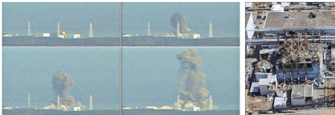
Figura 46. Istantanee dell'esplosione di Idrogeno avvenuta nell'unità 3, e condizione dell'edificio reattore dopo l'evento.
