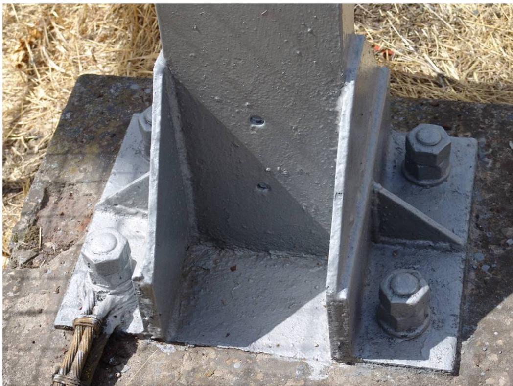
**Fig.5 Dettaglio del supporto verniciato**
