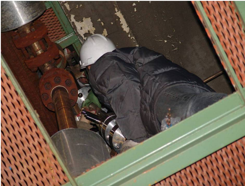
Fig. 6. 2 - Fasi di montaggio: inserimento barre dal piano 4° della Centrale Emilia
