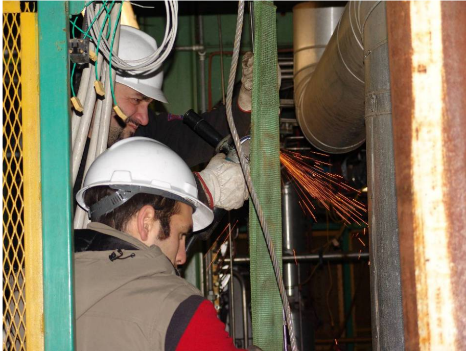
Fig. 6. 4 - Fasi di montaggio: lavori al piano 5° della Centrale Emilia per agevolare l'inserimento delle barre scaldanti
