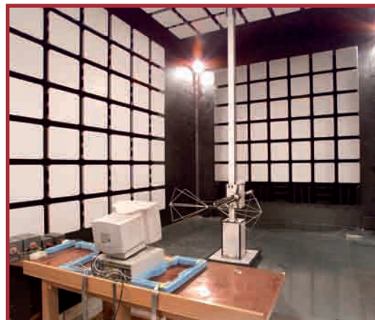
Vista interna della camera semianecoica "Vecuvia"
