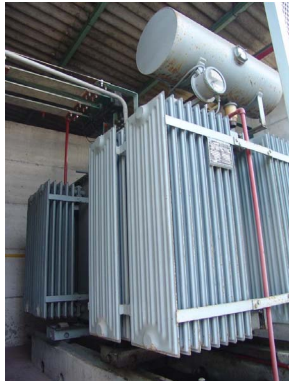
Figura n. 39 - Cabina GEST: Trasformatori 3000 / 380V (TR-1 e TR-2)
