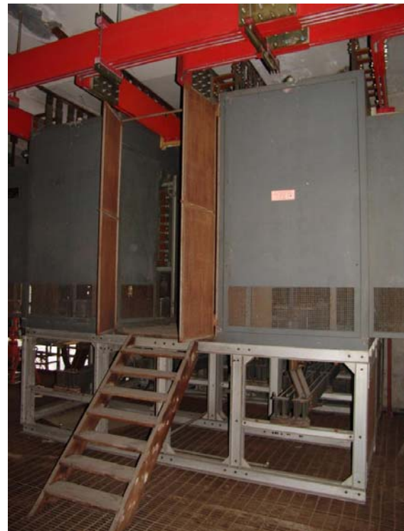
Figura n. 43 Armadio a Diodi Gruppo di Potenza 8 MW
