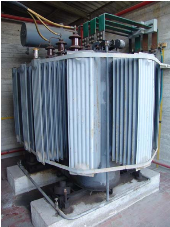
Figura n. 39 - Cabina GEST: Trasformatori 3000 / 380V (TR-1 e TR-2)
