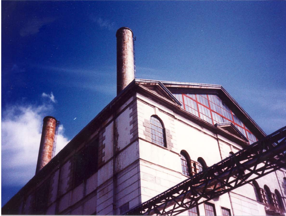
Figura n. 2 - La centrale Emilia
