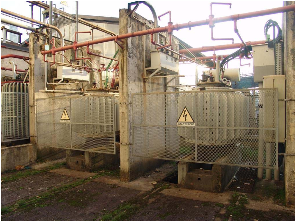
Figura n. 37 - Trasformatore TSP
