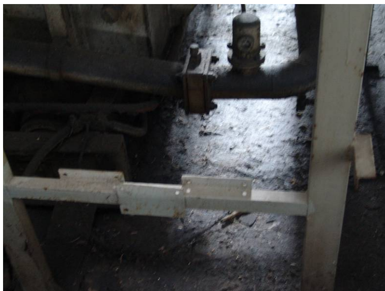
Figura 4 a,b,c - trafileamenti di olio da C.G.E. (particolari valvole e bacino raccolta olio)
