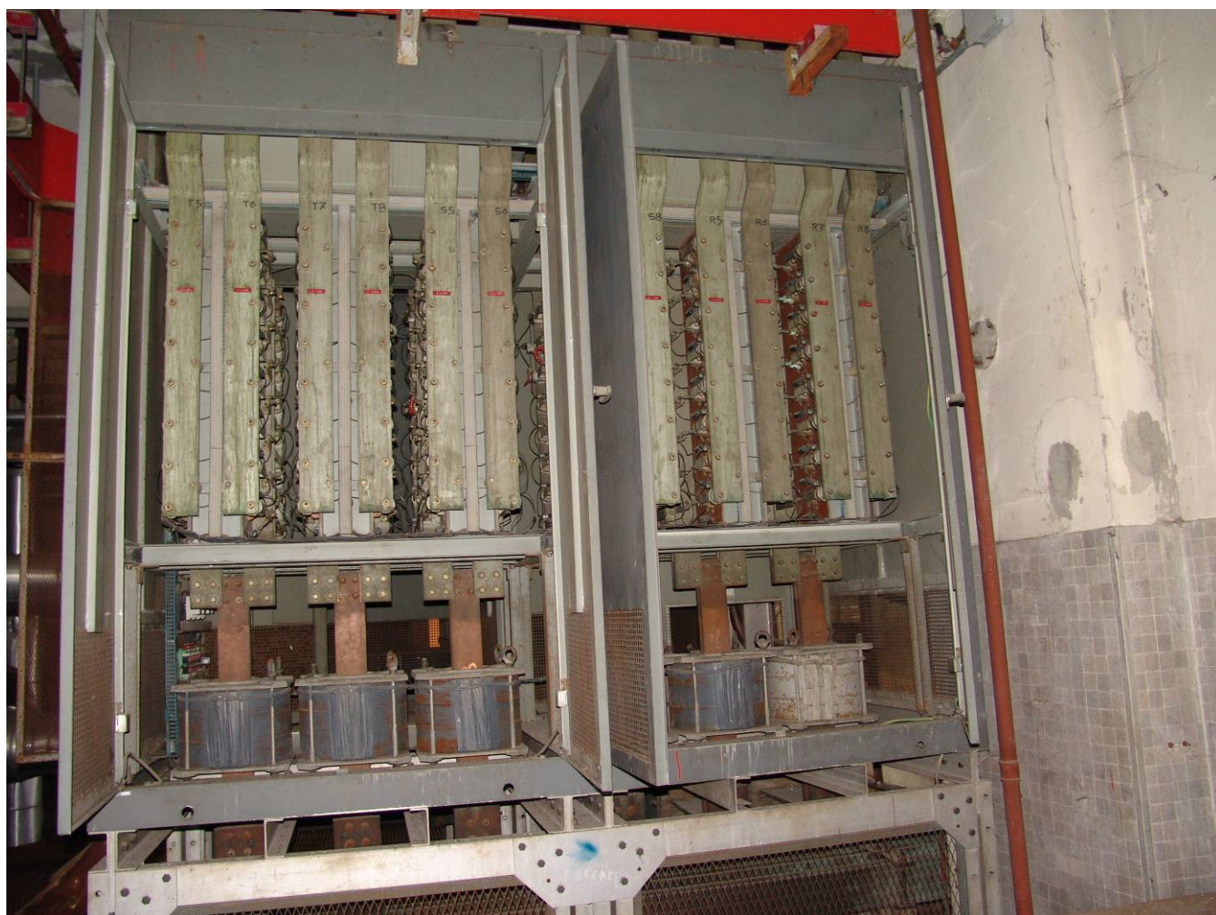
Figura 6 – Gruppo 8 MW C.G.E. zona raddrizzatori
