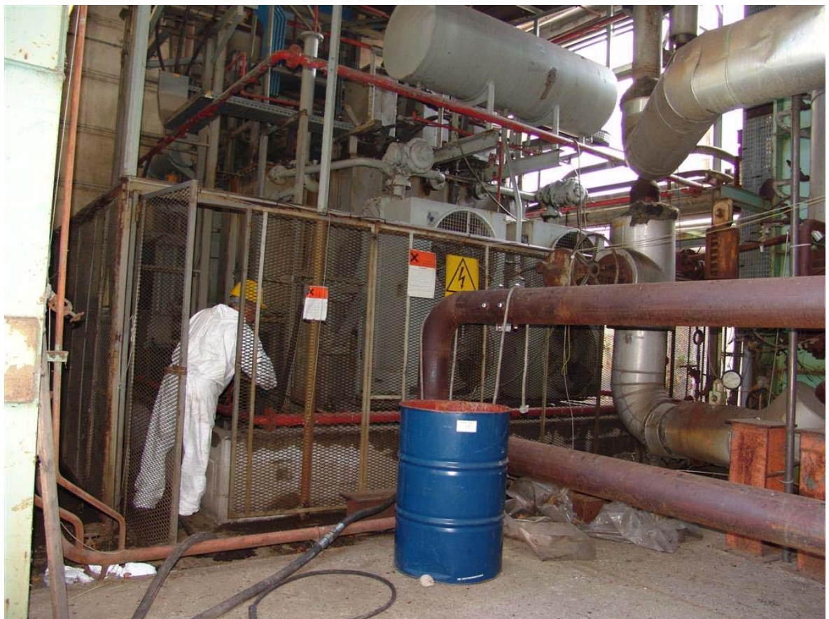
Figura 6 a,b - Lavori di manutenzione sul gruppo 8MW
