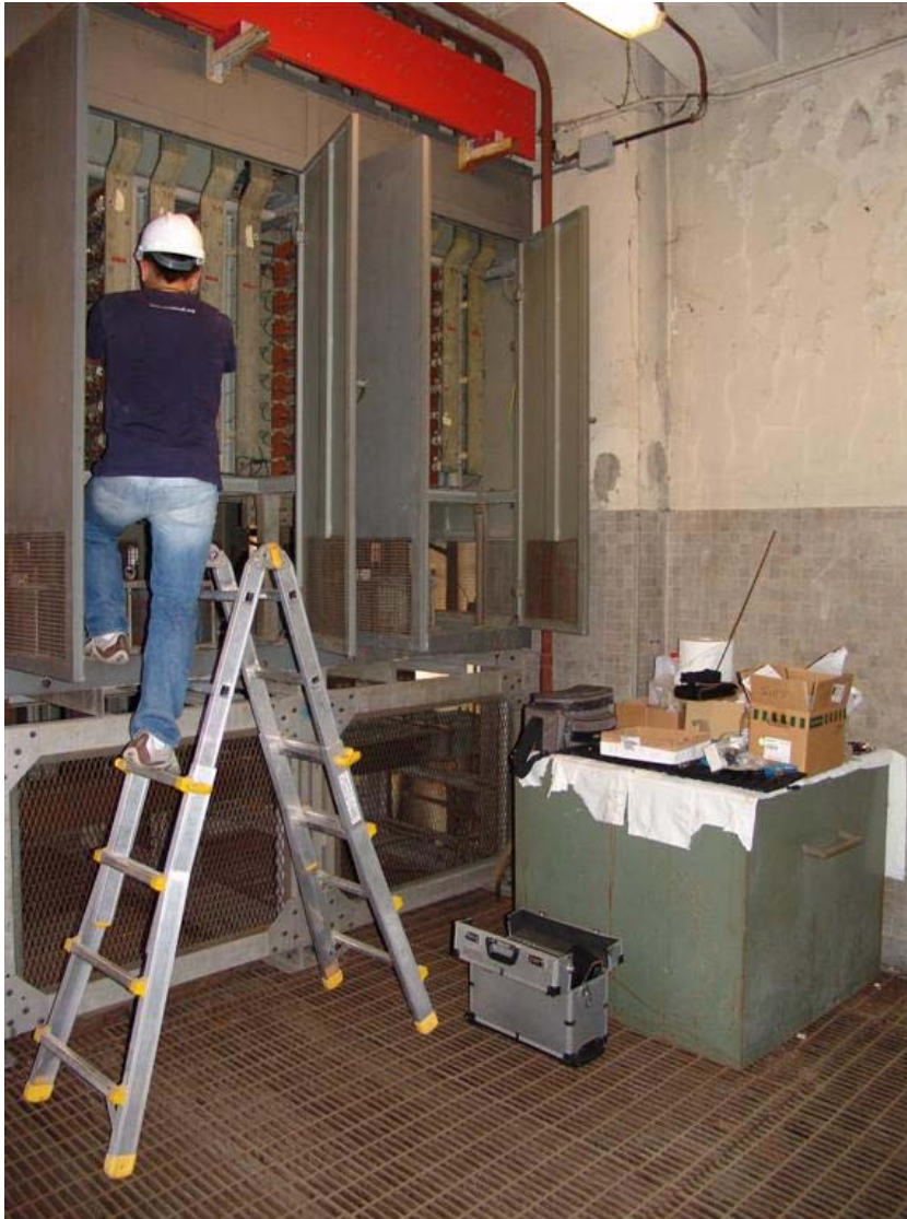
Figura 11 - Lavori di manutenzione al gruppo di raddrizzamento 8MW
