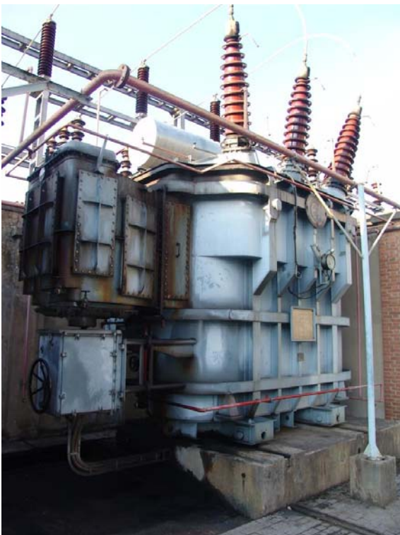
Figura 11 - TRASFORMATORE 130 / 3 KV
