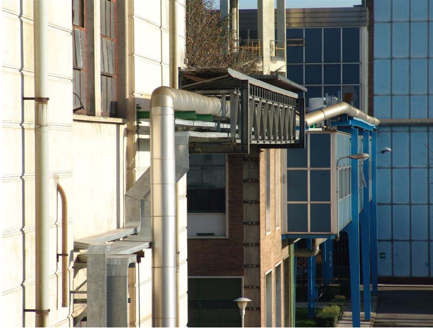
Figura 13 - LINEA 5" VAPORE SURRISCALDATO DA CENTRALE EDIPOWER
