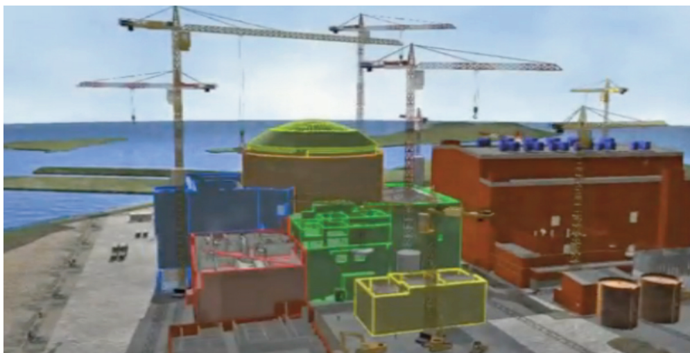
Stato del cantiere OL3 in Finlandia, febbraio 2010
