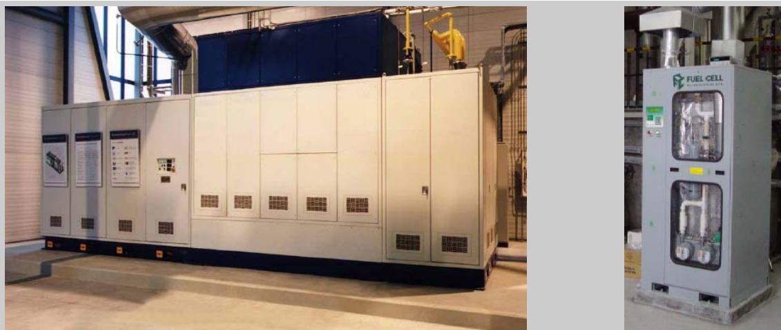
Figura 53 - Esempi di celle ad ossidi solidi.
