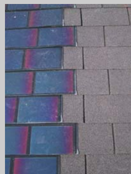
Figura 10 - Esempi di integrazione dei componenti fotovoltaici in manti di copertura su tetti a falda nel caso di coperture basse.
