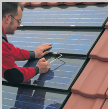
Figura 10 - Esempi di integrazione dei componenti fotovoltaici in manti di copertura su tetti a falda nel caso di coperture basse.
