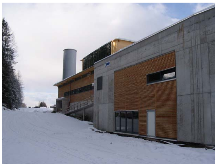
Figura 27 - Immagine della centrale. (Fonte: http://www.fti.bz/it/informazioni/impianto.html ).
