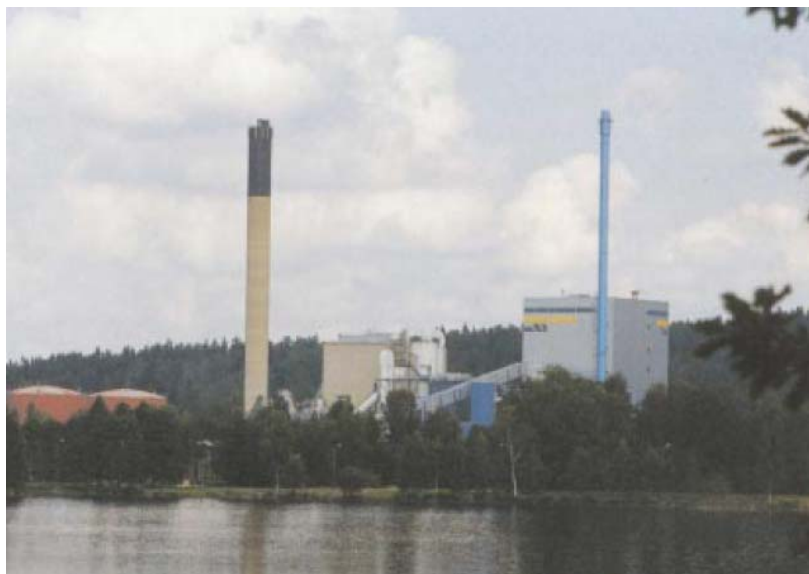
Figura 39 - Vista dell'impianto di cogenerazione Sandvik II.
