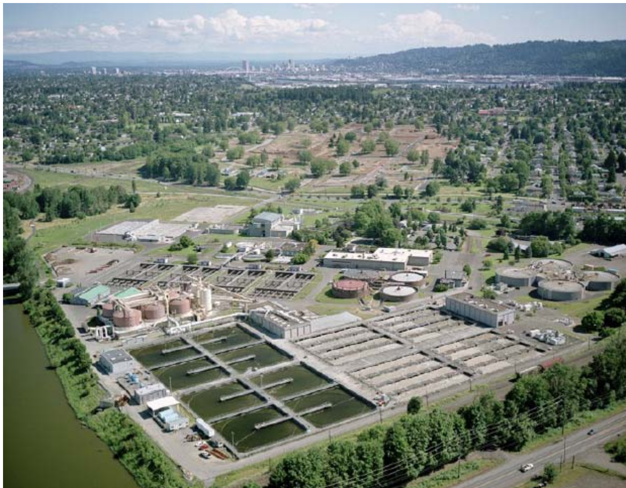
Figura 75 - Vista aerea dell'impianto Columbia Boulevard Wastewater Treatment Plant (CBWTP). (Fonte: www.eere.energy.gov ).
