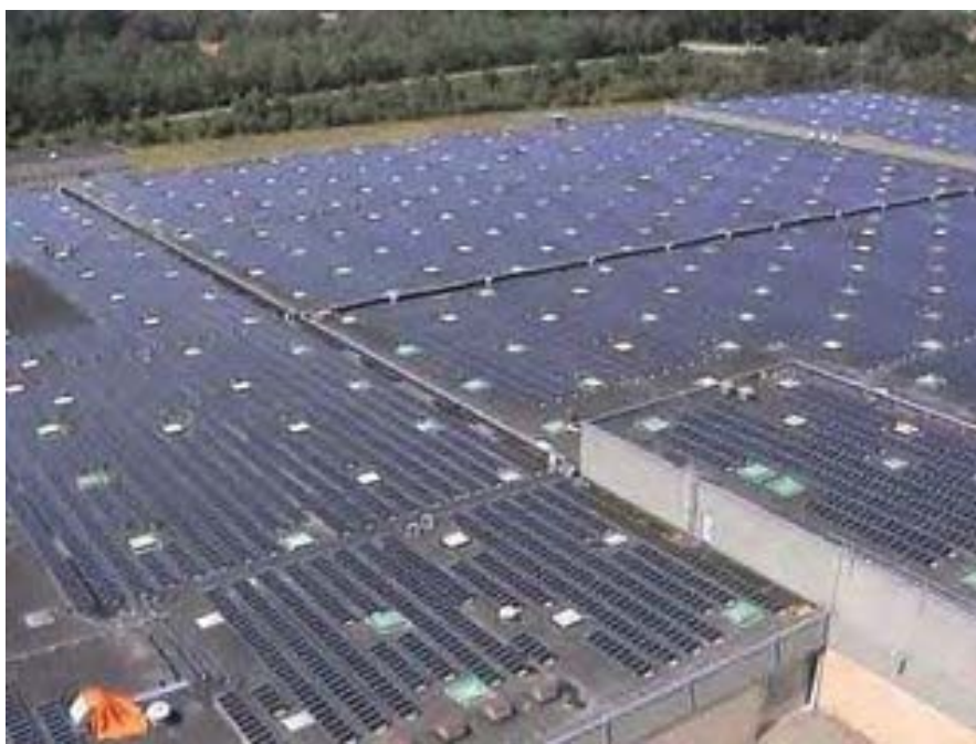
Figura 5 - Vista generale dell'impianto. (Fonte: http://www.colexon.de/en/leistungen/grossprojekte.html ).
