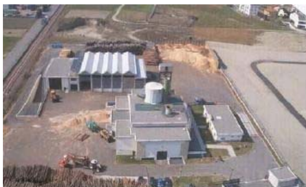
Figura 22 - Impianto a biomasse di Tirano. Fonte: http://www.climatepartner.de/italy/ .
