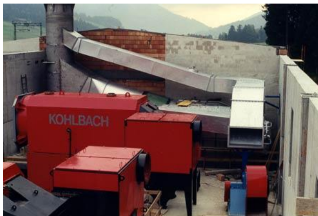
Figura 26 - Immagine dell'installazione della caldaia 1995. (Fonte: http://www.fti.bz/it/informazioni/impianto.html ).
