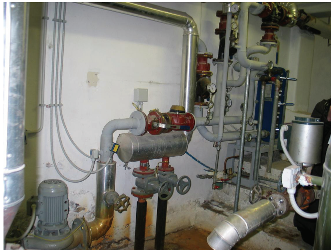
Fig. 41 - Sottocentrale termica
