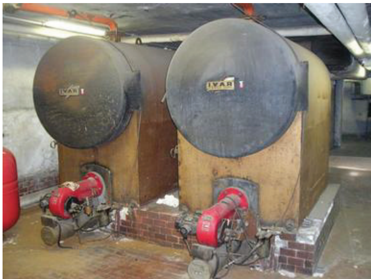
Fig. 18. Caldaie a gas
