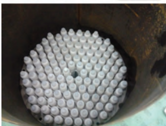
Sistema di accumulo PCM, vista dall'alto del serbatoio
