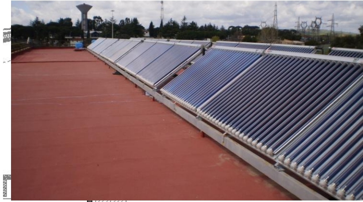
Pannelli solari a tubi evacuati ad Heat Pipe
