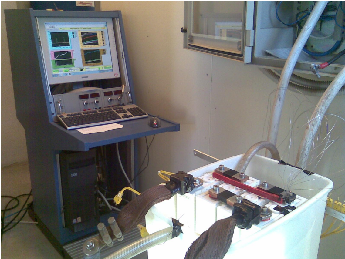
Fig. 23 – Impianto per prova di raffreddamento con acqua
