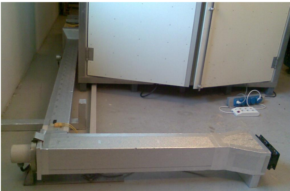
Fig. 20 – Realizzazione dell'impianto BA.CO
