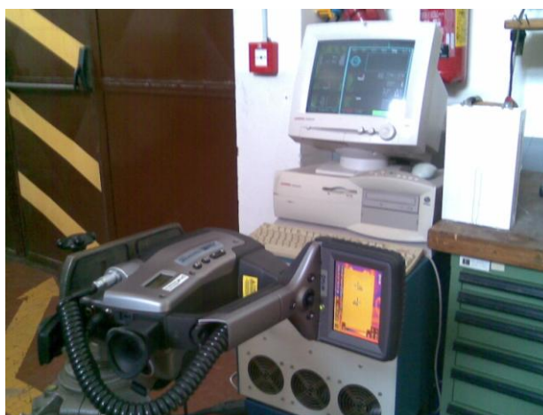
Fig. 10 –Termografia su batteria in esercizio
