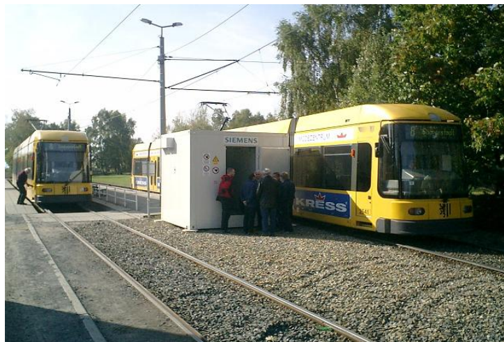
Figura 4.5 – Sistema tramviario abbinato ad un sistema di accumulo stazionario a supercondensatori nella città di Dresda, Germania. Accumulo su supercondensatori Maxwell Technologies ed elettronica di potenza Siemens.
