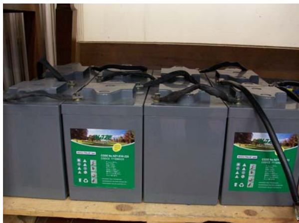
Fig. 6.2.1) Batterie HAZE 6V 200Ah n. 8 moduli 48 VDC.
